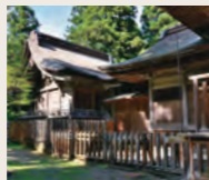
殖生護国八幡宮(国指定重要文化財) ◎無料 ▲小矢部市殖生2992(石動駅から徒歩25分/小矢部I.Cより車で10分) ▲0766-67-1220
