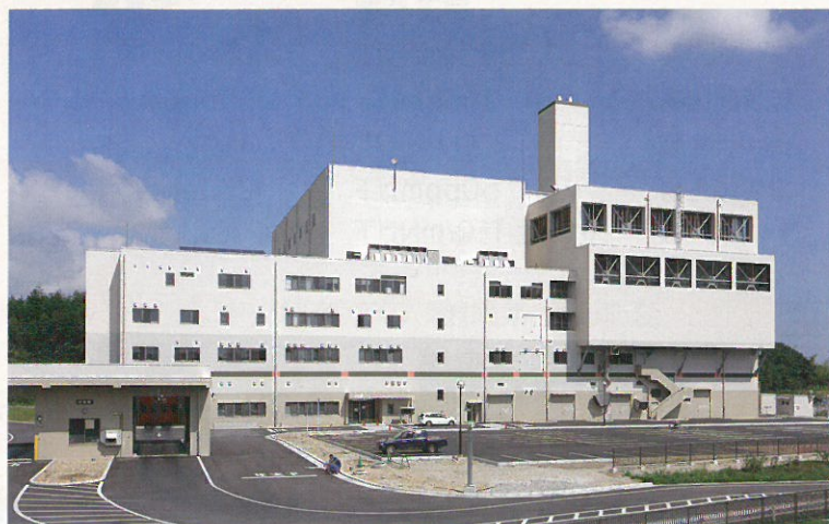
高岡広域 エコ・クリーンセンター外観
